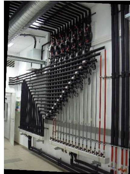
16. ábra: Fűtő- és hűtő hőhordozó elosztó rendszer
