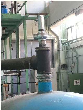
1. ábra. Bal oldal: ipari példa NyHSz beépítésére. Jobb oldal: vázlat tipikus NyHSz elrendezésre.
